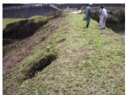
堤体の陥没
