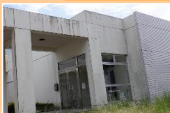
安全性評価実験施設改修
