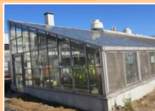
隔離温室改修
