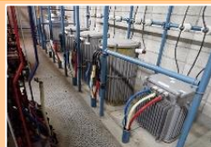
受変電施設等改修
