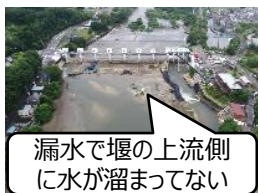
頭首工の漏水事故 (上流側より俯瞰)
