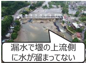
頭首工の漏水事故 (上流側より俯瞰)
