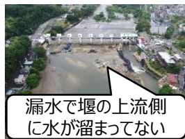
頭首工の漏水事故 (上流側より俯瞰)
