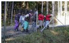
大人数での柵の設置作業
