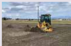
ICT均平化施工
