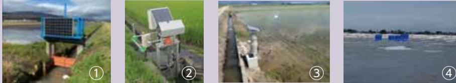
目標 用排水ゲートの自動化により、豪雨時の見回りを減少させ、事故発生数を限りなくゼロに。スマート水管理システム導入で水田由来の排水量ピークを最大70%カット、水管理労力を最大50%削減。
