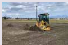
ICT均平化施工
