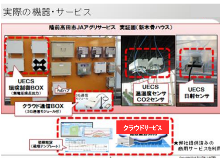
図1 ユビキタス環境制御システム(UECS)機器の設置状況 実証システム
