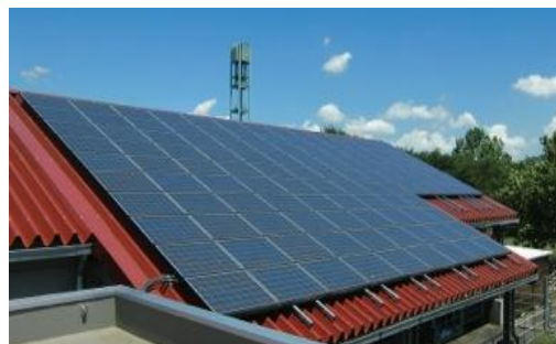
牛舎の屋根に設置した太陽光発電パネル
