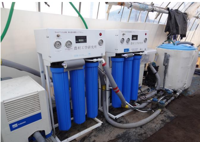
農業用逆浸透膜装置の現地実証試験
