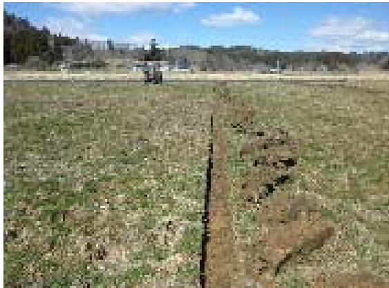
溝掘機による明きよ施工
