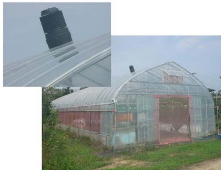
簡易(小型)換気扇の設置
