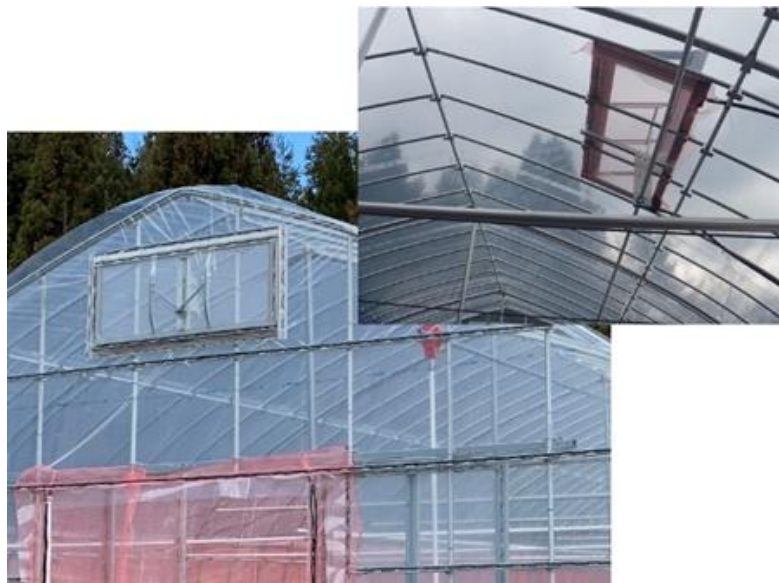
妻窓と天窗の設置
