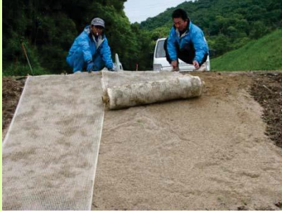
二重ネットの敷設作業
