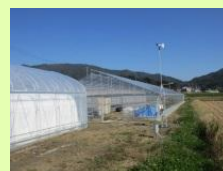
陸前高田市に施工した 建設用足場利用ハウス
