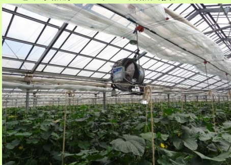
循環扇を設置した現地実証温室
