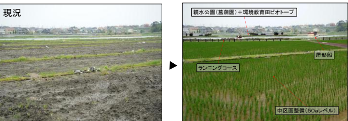
図5 被災した水田を復旧し、併せて環境整備を実施(事例)
