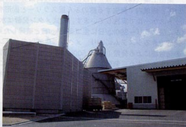
写真4 木くずを燃料に熱と電気をつくる「エコ発電所」のボイラー設備（岡山県勝山町）（写真提供：木質バイオマス研究会）
