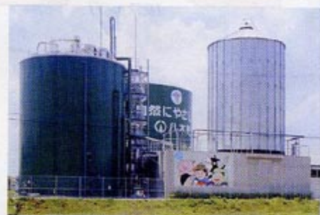
写真5 八木町農業公社湿式メタン発酵プラント（写真提供：八木町）
