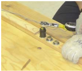
摩擦力を発生させる木材圧縮力の管理法を確立
