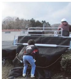
ロープ固定式資材の活用による効率化
