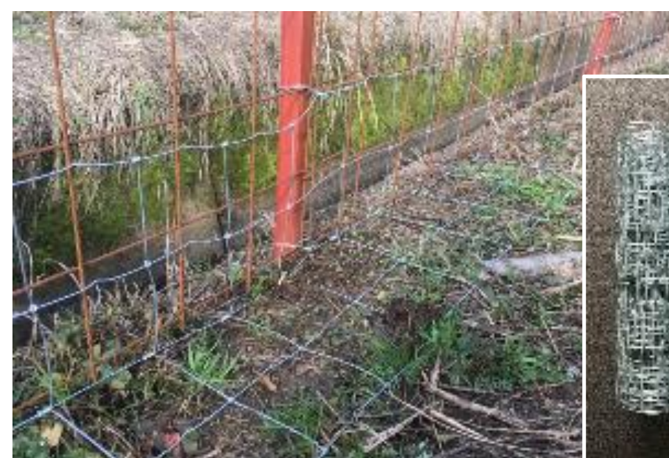
防護柵下部の簡易補修資材
