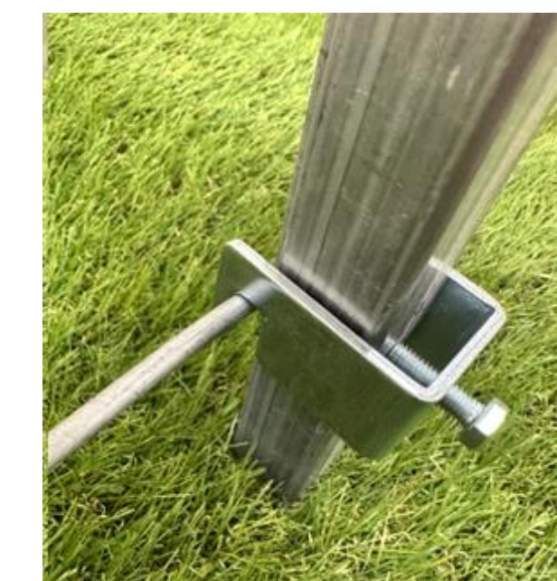
柵下部の補修を簡単にできる留め具
