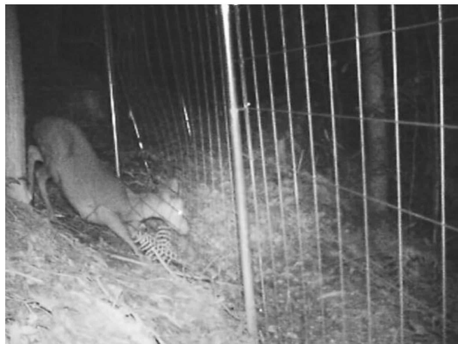
補修が必要な防護柵
