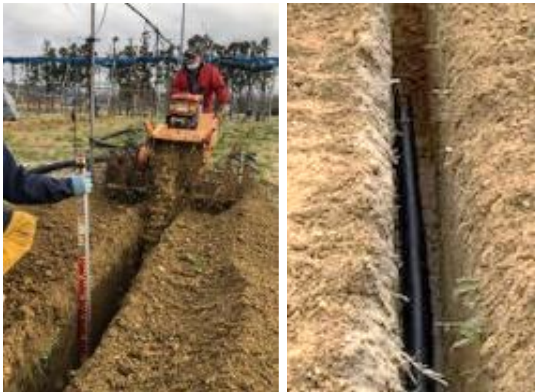
水田転換園での暗きょ設置の様子
