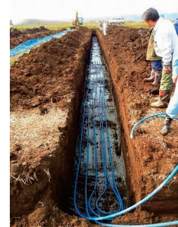
図3 水平配管方式
