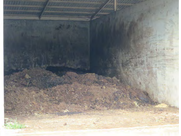
臭気が問題となる堆肥化処理施設
