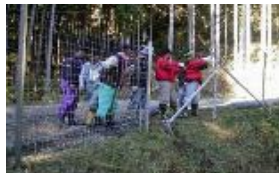
大人数での柵の設置作業
