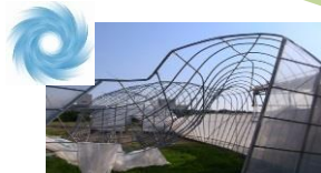
台風被害で倒壊した農業用ハウス
