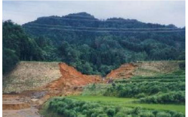
ため池の被災事例
