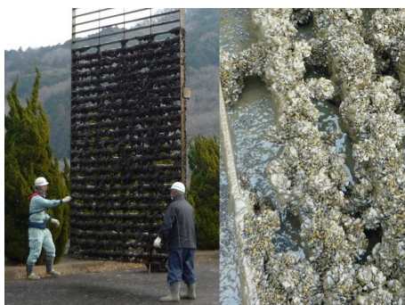
水利施設のスクリーンに張り付いたカワヒバリガイ
