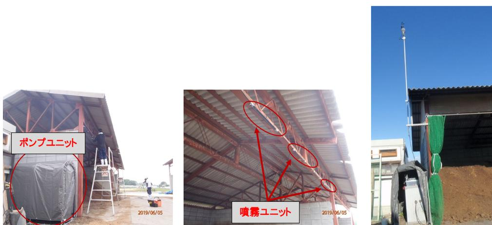
図2 流体カーテンシステムの設置と噴霧制御システムの構築
