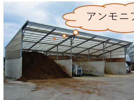
臭気が問題となる堆肥化処理施設
