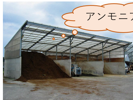
臭気が問題となる堆肥化处理施設
