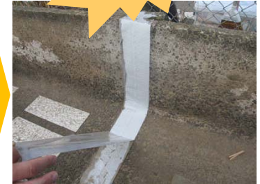
④養生テープの除去、完成
