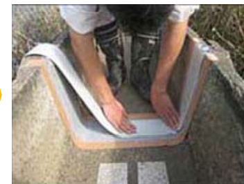
③高耐久性テープの貼り付け
