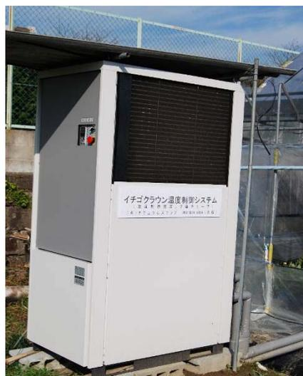
冷温水製造装置(インバータ式)
