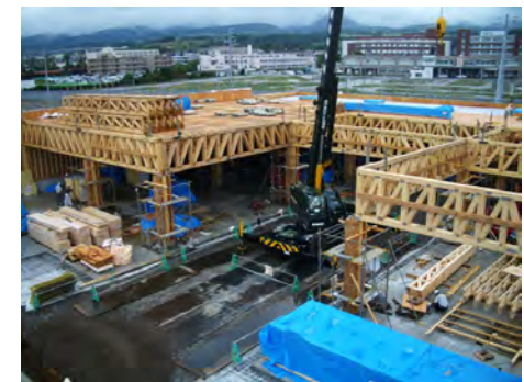
2x4工法を利用した 大規模木造建築物
