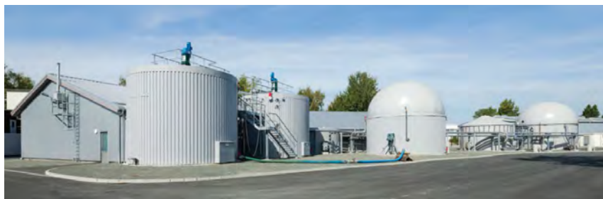
▲ バイオガスプラントの外観
