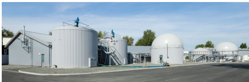
▲ バイオガスプラントの外観
