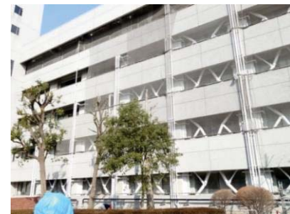
研究本館耐震 改修工事
