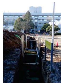
上水設備 改修工事
