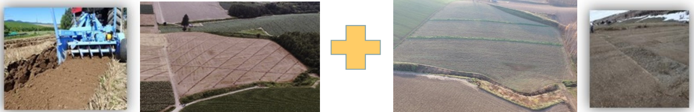
土層改良の実施(カットソイラー)
