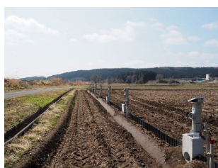
現地水田におけるICT水管理装置の設置状況
