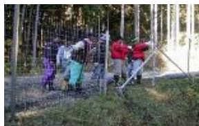
大人数での柵の設置作業
