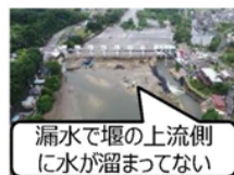
頭首工の漏水事故 (上流側より俯瞰)
