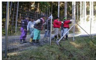
大人数での柵の設置作業
