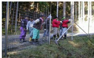
大人数での柵の設置作業
