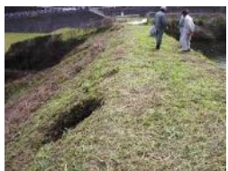
堤体の陥没
