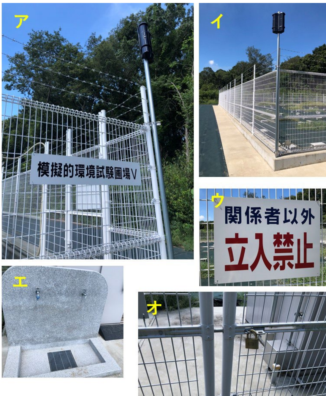
図5 隔離ほ場施設写真 13
