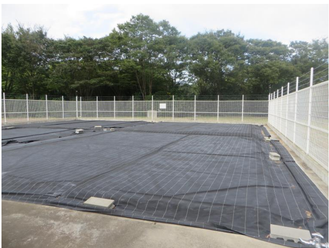
隔離ほ場内部
