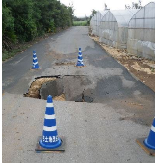
農業用パイプラインの漏水・道路陥没事例
