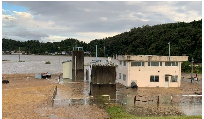
豪雨によって浸水した排水機場
