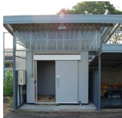
図6 貯桑室（クワを保管する冷蔵室）
