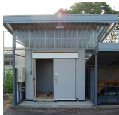
図6 貯桑室（クワを保管する冷蔵室）
