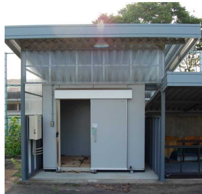
図6 貯桑室（クワを保管する冷蔵室）
