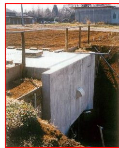
地下室型土層別窒素溶脱観測施設の開発により、地下における窒素の動態を解明
