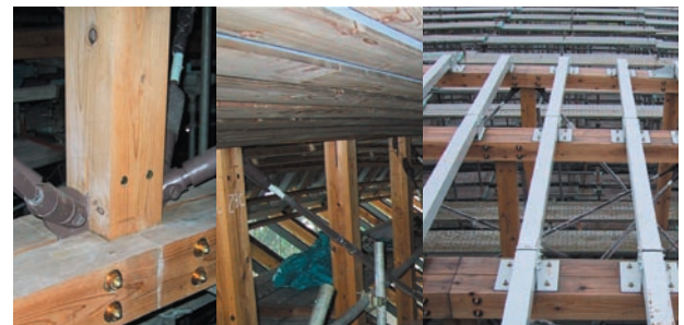
図 17 スギ人工乾燥材を活用した体育館の建設
