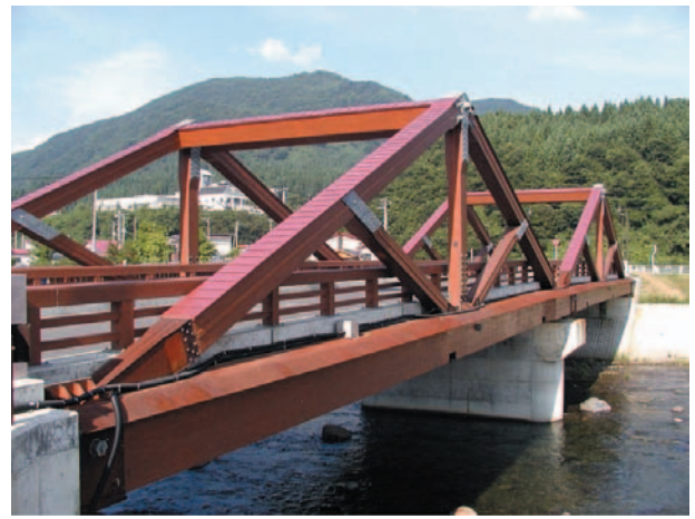
図 33 スギ集成材で造られた木橋
