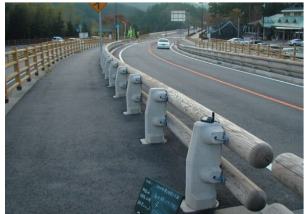
図 34 スギ丸太で作られたガードレール
