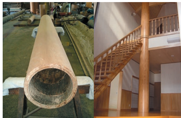
図 31 円筒 LVL（左）を用いた柱（右）
